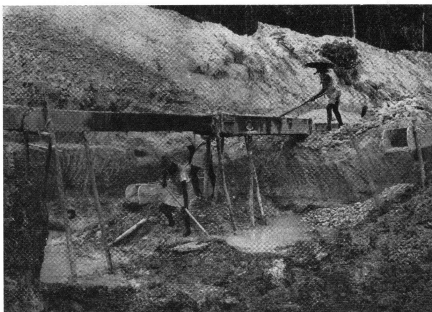
Fig. 3. Exploitation van goudhoudende alluvia met behulp van de sluis. Exploitation of goldbearing gravel with sluice-boxes.
